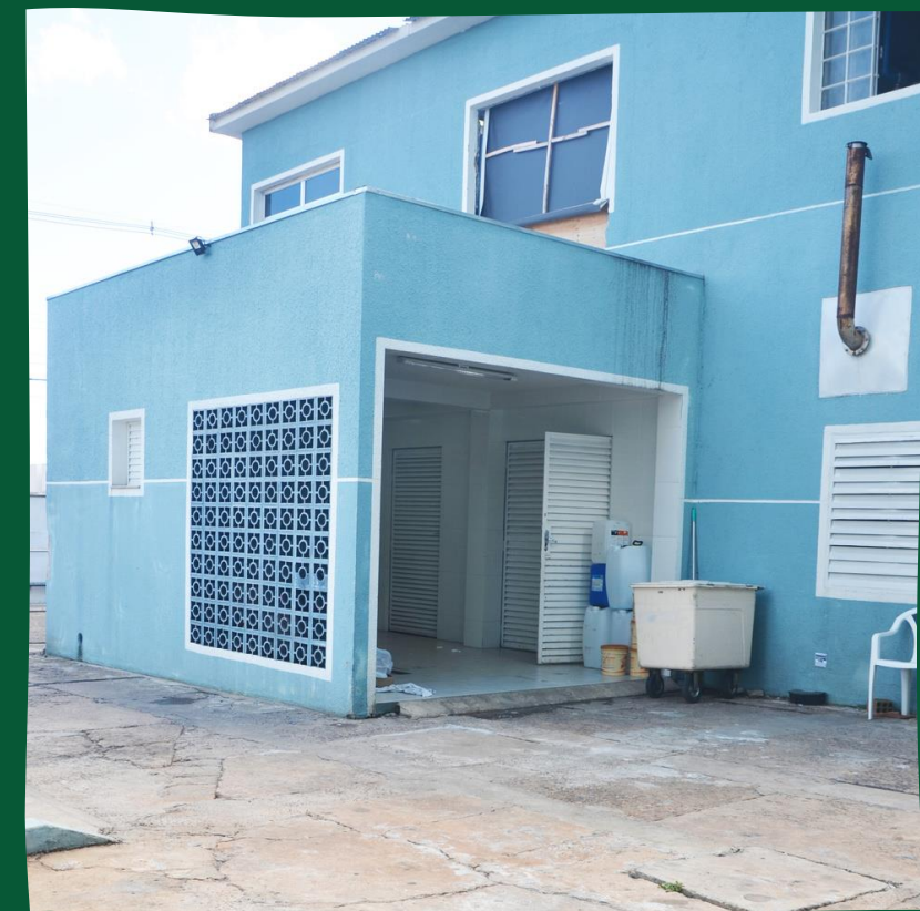
CENTRAL DE RESÍDUOS
